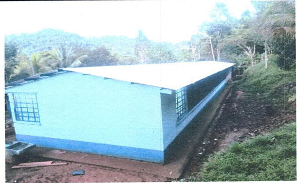
Foto 2: Panorámica posterior y techo despues de remozado (42 metros de largo por 8 metros de ancho).
