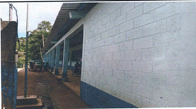
Foto 5: vista frontal, paredes remozadas con pintura.
