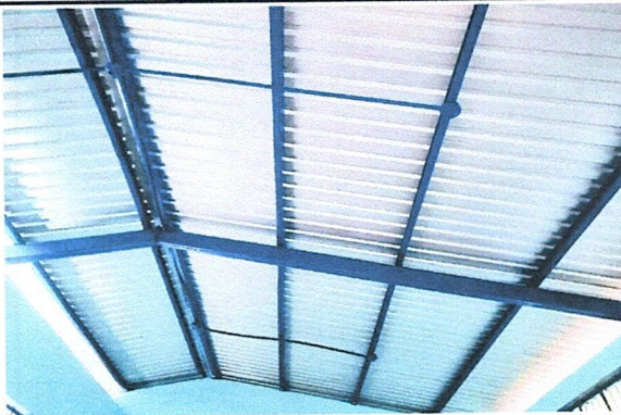
Foto 3: Estructura metálica de cubierta con mantenimiento preventivo
